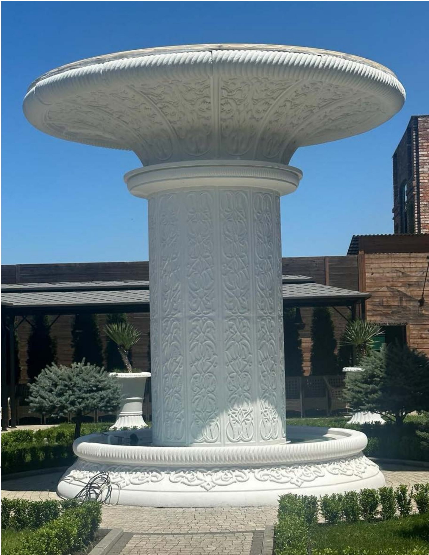
Колонны фонтана из стеклофибробетона в Осетии
