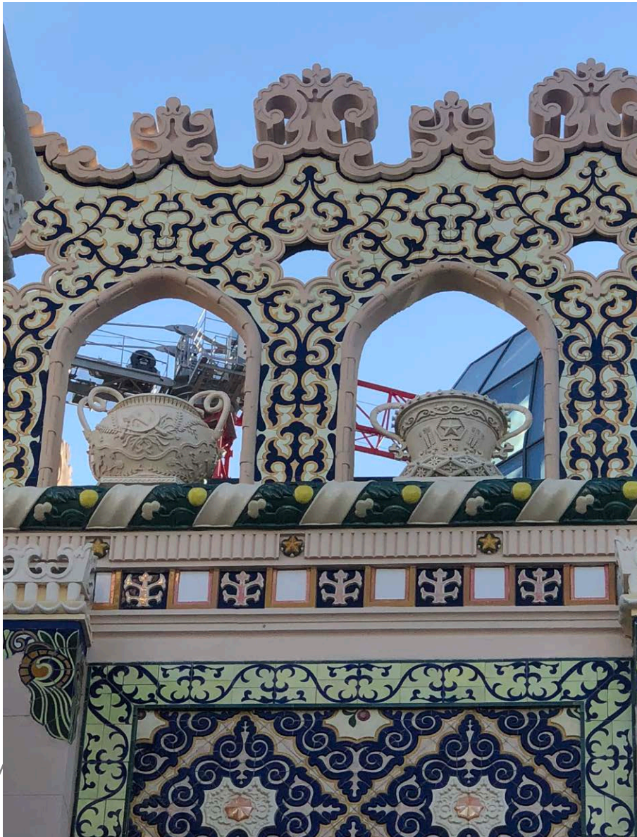
Реставрация вазонов из стеклофибробетона на фасаде павильона
